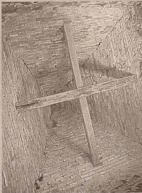
A foto ilustra o sistema construtivo dos arremates das torres tradicionais de nossa igreja. Totalmente em tijolos maciços, o serviço é executado em forma de pirâmide, cujas sucessivas fiadas vão se fechando até atingir o cume. Embora o acabamento exterior seja totalmente nivelado com revestimentos de emboço e reboco, seu interior permanece do tipo "a vista", facilitando a compreensão de sua técnica construtiva.
